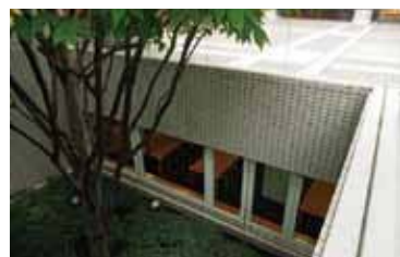
図10 | 中庭から図書館を見る
