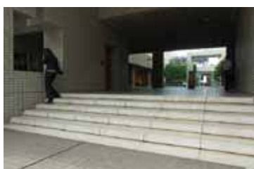
図7 | 南側ファサードから中庭を見る
