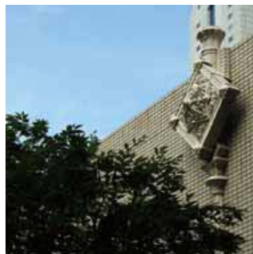
図5 | 新建築会館に引き継がれた旧会館の細部(中庭に面した壁面上部)
