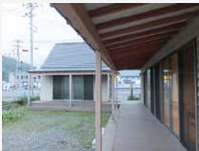
図2 中庭と2棟をつなぐウッドデッキ [2016.8、筆者撮影]
