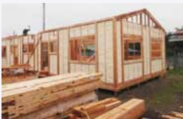
図5 | 木造仮設住宅の断熱仕様例
