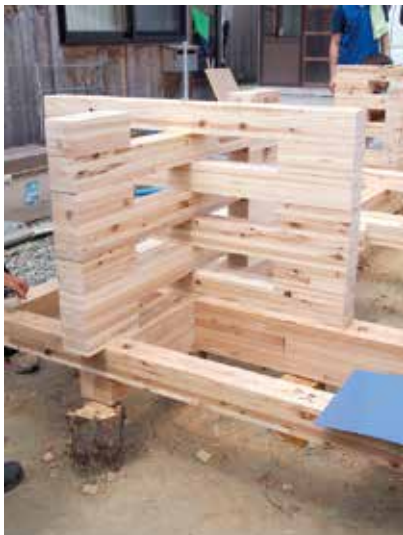
図3 モブロックを積み上げた構法の柱
